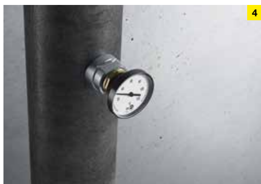
4. Ir pabeigts ideālais pieslēgums tērauda caurulei piemēram, termometram, manometram vai iztukšošanai.
