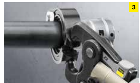
Veidgabals tiek dažās sekundēs sapresēts ar Viega presēšanas instrumentu un izveidots neizjaucams savienojums ar cauruli.
