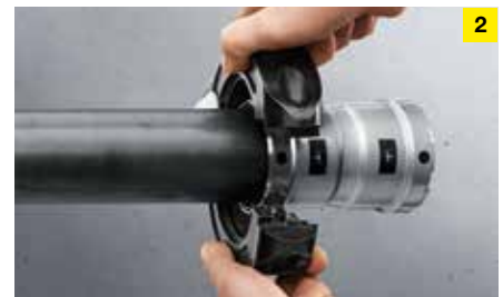
Lai presētu Megapress veidgabalus, kas lielāki par 1¼ collām, tiek izmantoti tikai presēšanas gredzeni ar šarnīržokļiem. Mazākiem izmēriem, no ¾ collas līdz 1 collai, var izvēlēties gan presēšanas žokļus, gan presēšanas gredzenus ar šarnīržokļiem.
