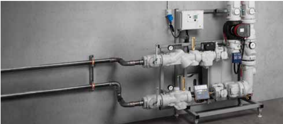
Cauruļvadu sistēma Megapress S XL pārliecina ar auksto presēto savienojumu tehniku un ievērojamu instalācijai nepieciešamā laika ietaupījumu.
